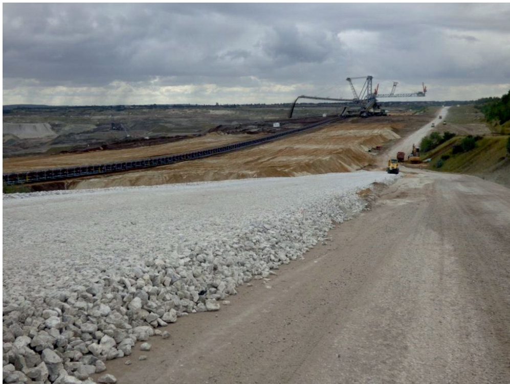
Fot. 3.7. Wykorzystanie wapieni do podbudowy drogi technologicznej w KWB Bełchatów
