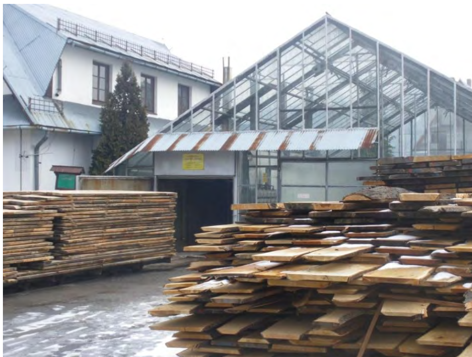
Ryc. 10.6.1. Suszarnia drewna – jeden z elementów kaskadowego zagospodarowania energii geotermalnej w obiektach IGSMiE PAN w Bańskiej Niżnej na Podhalu (arch. IGSMiE PAN)
