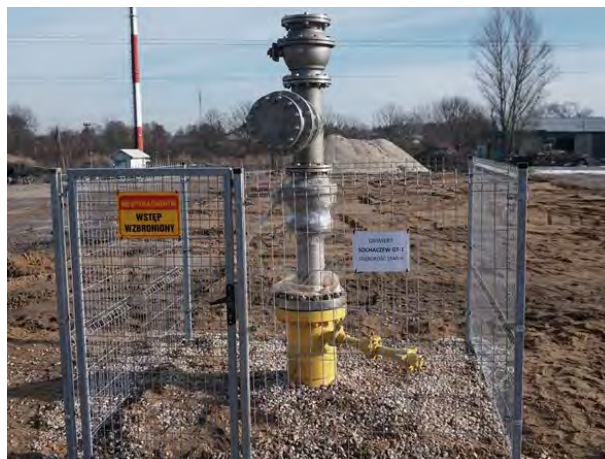
Ryc. 20.3.3. Wylot otworu Sochaczew GT-1 – zabezpieczony i ogrodzony. Maj 2022 r. (fot. Arch. Gminy Miasta Sochaczew)
