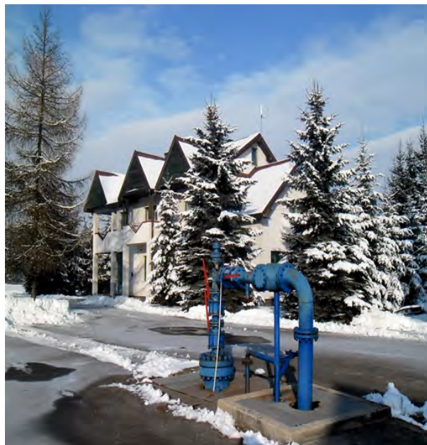
Ryc. 10.2.1. Głowica otworu Bańska IG-1 – pierwszego w Polsce, z którego wydobywana jest woda geotermalna do celów ciepłowniczych (od 1992 r.), początkowo w ramach Doświadczalnego Zakładu Geotermalnego PAN Bańska-Biały Dunajec (fot. arch. IGSMiE PAN)
