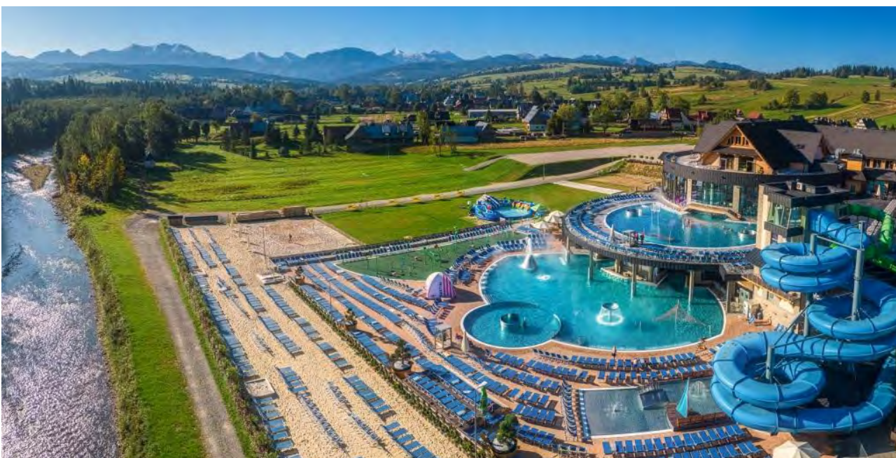
Ryc. 10.4.2. Chochołowskie Termy – jeden z siedmiu geotermalnych ośrodków rekreacyjnych na Podhalu. Otwarty w 2016 r. (arch. Chochołowskie Termy sp. z o.o.)
