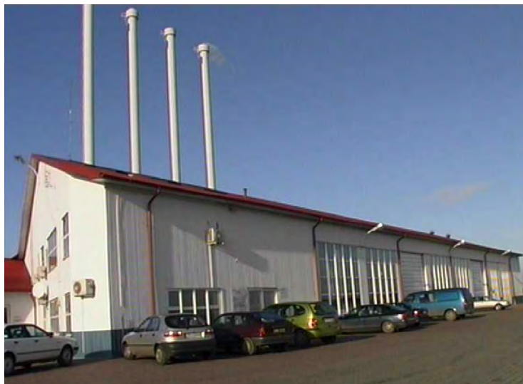
Ryc. 10.2.3. Budynek ciepłowni geotermalnej w Pyrzycach – widok ogólny (arch. Geotermii Pyrzyce sp. z o.o.)
