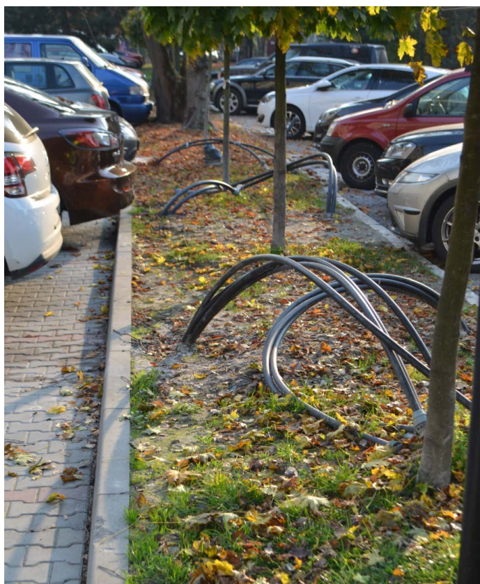
Rys. 7. Nowe pole badawcze otworowych wymienników ciepła na terenie Akademii Górniczo-Hutniczej w Krakowie (2017 r.)
