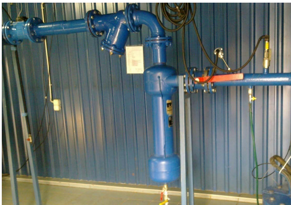
Rys. 34. Instalacja wydobywcza ujęcia wód termalnych Mszczonów IG-1 (fot. B. Bielec)
