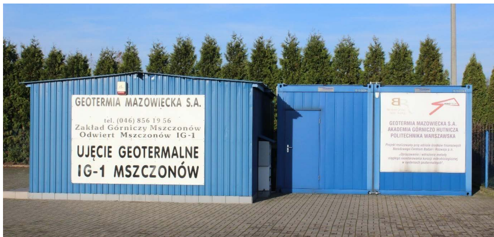
Rys. 32. Widok na obudowę ujęcia geotermalnego Mszczonów IG-1 – z lewej. Obok widoczna obudowa stacji badawczej (fot. M. Słówek)
