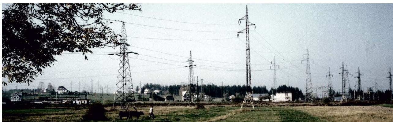
Rys. 2.62. Linie energetyczne naziemne wysokiego i średniego napięcia emitują do otoczenia około 12% przesyłanej w Polsce energii to jest około 18 Terawatogodzin rocznie (68 000 Tj energii cieplnej), ze 150 TWh energii elektrycznej wyprodukowanej kosztem ponad 1 080 000 Tj energii cieplnej zawartej w paliwie zużytym w elektrowni [http://www.rp.pl/artykul/649811-Straty-w-przesyle-siegaja-w-kraju-12-proc-energii-rocznie.html; publikacja: 28.04.2011; aktualizacja: 28.04.2011, 01:30] (Foto S.O. 1999)
