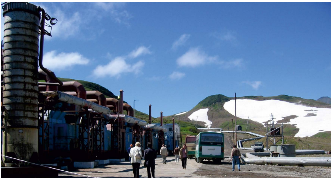
Rys. 3.19. Kamczatka, widok ogólny otoczenia elektrowni geotermalnej (Foto S.O. 2004)
