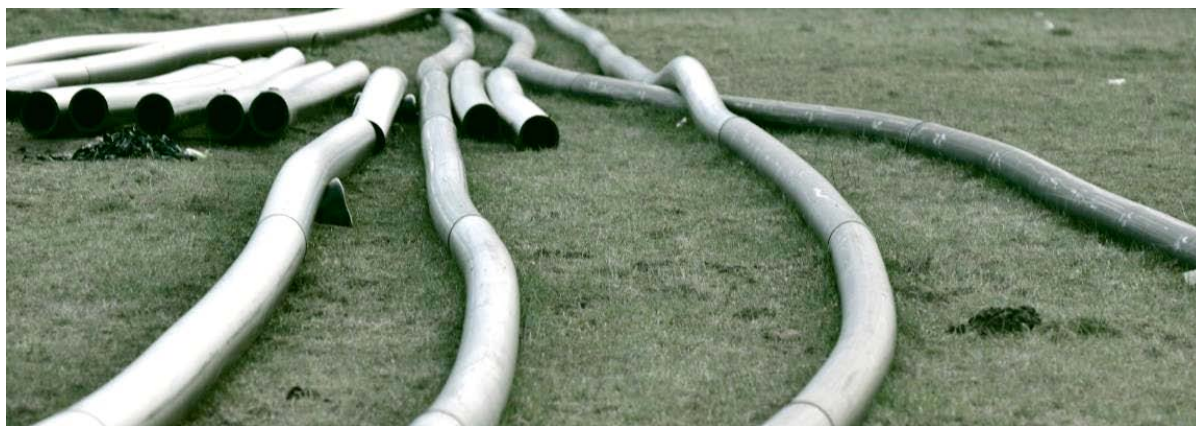
Rys. 2.26. Plastikowe rury osłonowe podziemnej sieci energetycznej WN przygotowane do zainstalowania (Foto S.O. 2015); potencjalny żer dla nowej generacji bakterii żywiących się plastikiem
