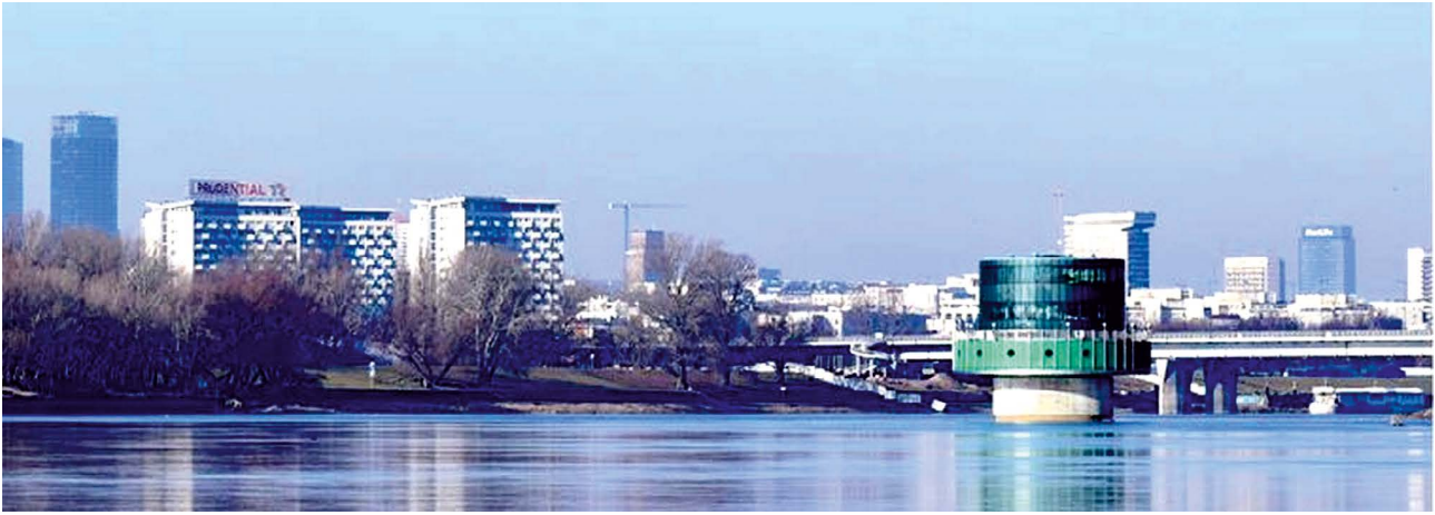
Rys. 2.63. Nadbudowa jednej ze studni do pobierania dla wodociągów miejskich wody przesączającej się przez piaski pod dnem Wisły w Warszawie; na dalszym planie miasto zanurzone w lekkim, brunatnym smogu porannym (Foto S.O. 2015)
