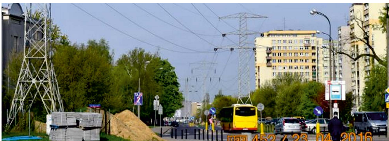
Rys. 2.17. Sytuacja terenowa kilkudziesięcioletniej napowietrznej linii elektroenergetycznej prądu przemiennego wysokiego napięcia (WN) poprowadzonej nad ruchliwą ulicą miejską; elektroenergetyczna linia kablowa czeka już pod ziemią na przyłączenie (Foto S.O. 2016)
