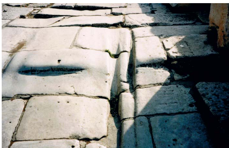
Fig. 3.26. Koleiny wyrzeźbione w bruku metalowymi obręczami kół pojazdów w ruchu ulicznym w Pompejach na początku I w. Miejska komunikacja kołowa była intensywna już w starożytności i sądząc z kolein uciążliwa dla pasażerów i okolicznych mieszkańców (Foto S.O. 1995)
