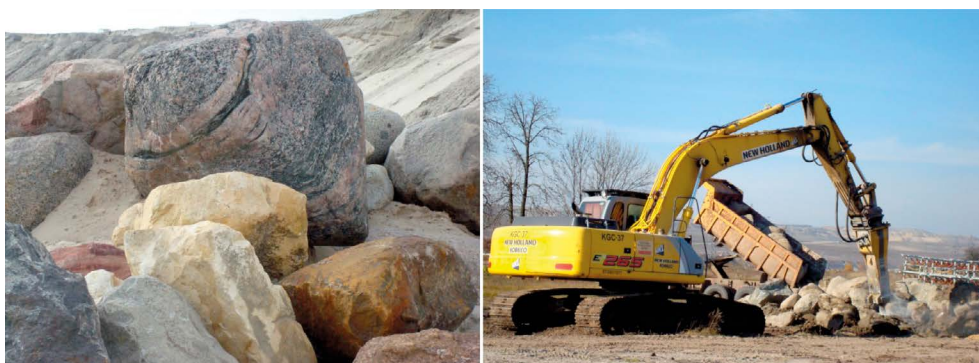
Fot. 5. Głazy narzutowe rozbijane młotem pneumatycznym
