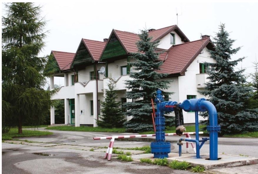
Rys. 4.2. Głowica otworu Bańska IG-1 na tle budynku głównego Laboratorium Geotermalnego w Bańskiej Niżnej
