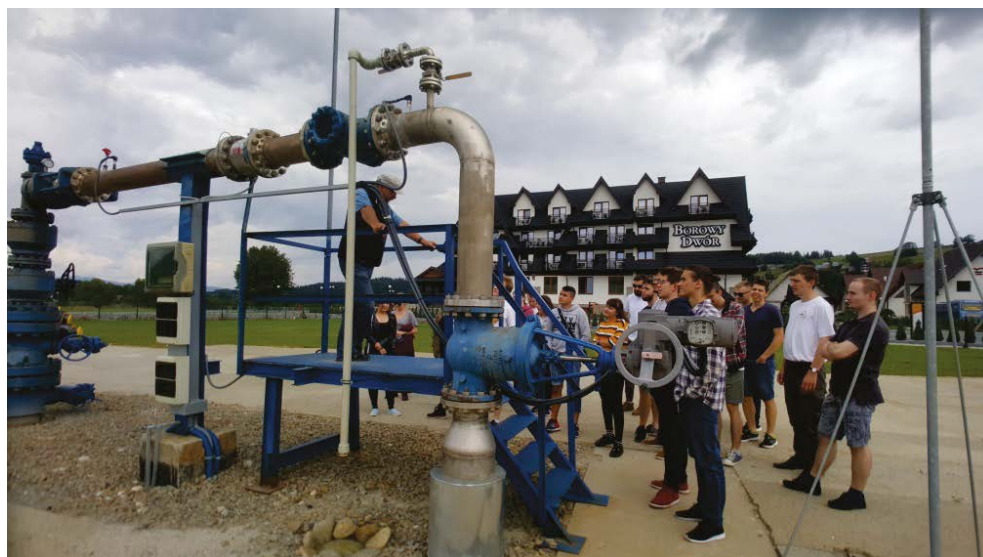
Rys. 1.5. Otwór geotermalny Bańska PGP-1, Geotermia Podhalańska SA (fot. A. Kasztelewicz)
