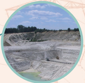
Kopalnia Piasku Kwarcowego Grudzeń Las
