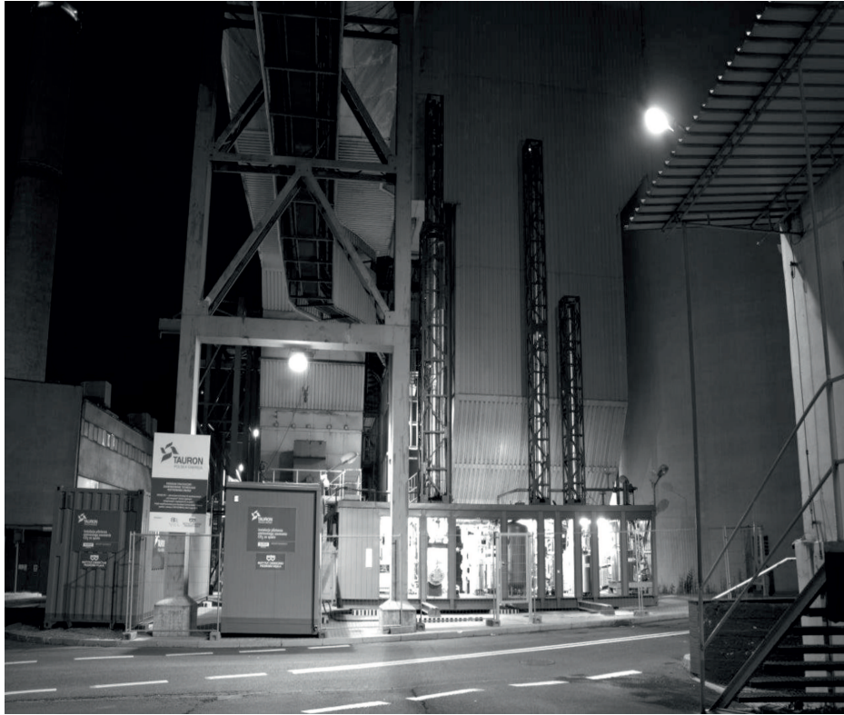
Rys. 2. Widok Instalacji Pilotowej absorpcyjnego usuwania CO 2 ze spalin w Elektrowni Łaziska w trakcie całodobowych testów technologicznych
