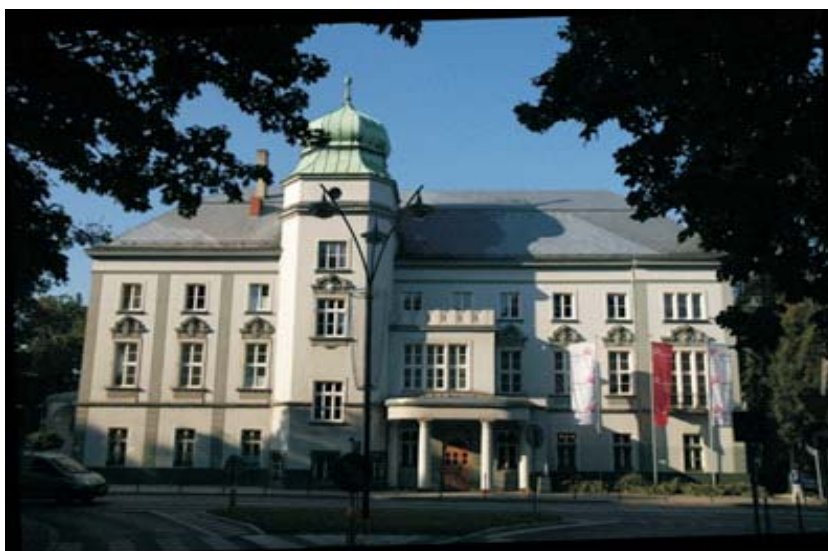
Fot. 1. Siedziba Południowego Koncernu Węglowego S.A. w Jaworznie
