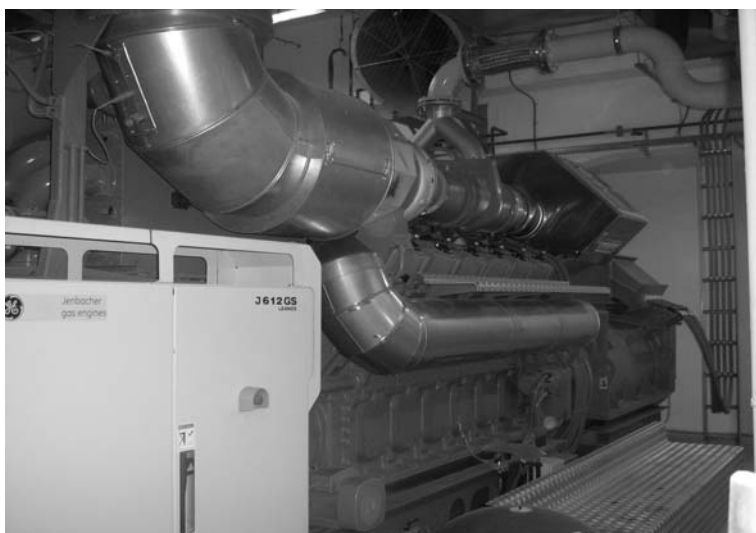
Rys. 4. Agregat zainstalowany w kopalni Borynia
