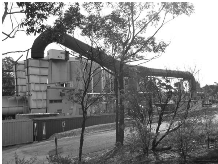
Rys. 7. „West Cliff” otwarte połączenie kapturem wylotu jednego z szypów z Vocsidizerem
