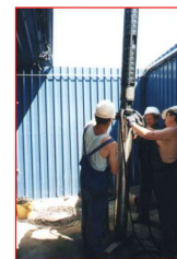
Zapuszczanie agregatu pompowego do odwiertu
