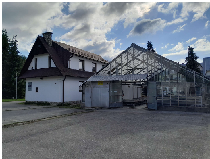
Zrewitalizowane obiekty wymyennikowni, suszarni oraz szklarni geotermalnej
