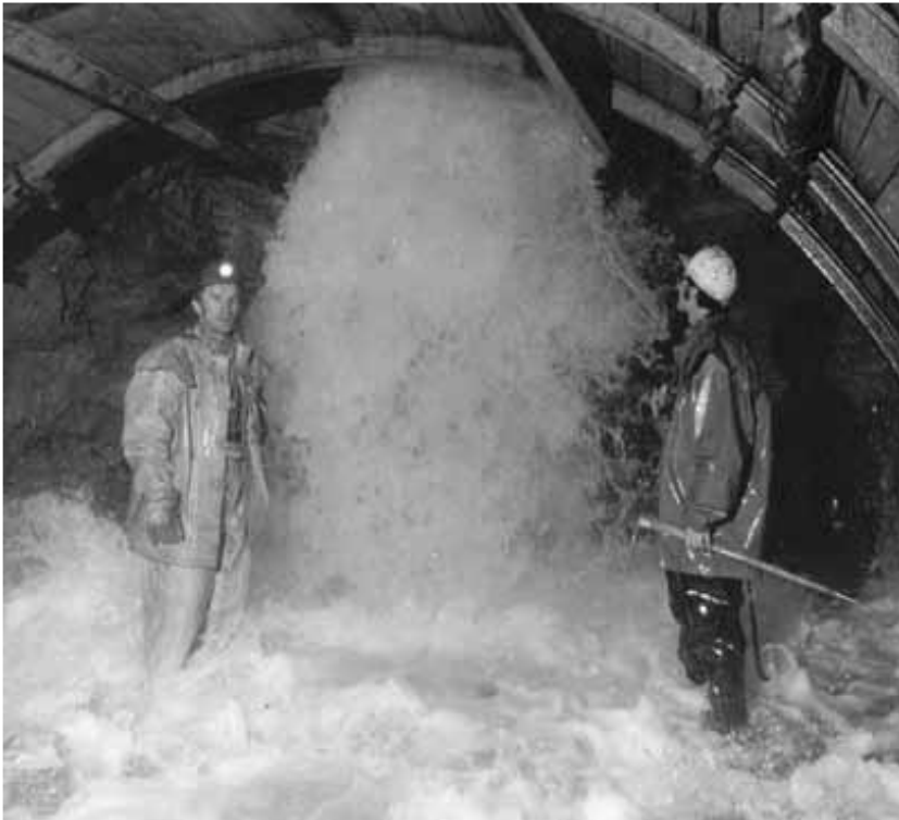
Wyływy wody z chodnika w kopalni „Olkusz-Pomorzany” (2001 r.)
