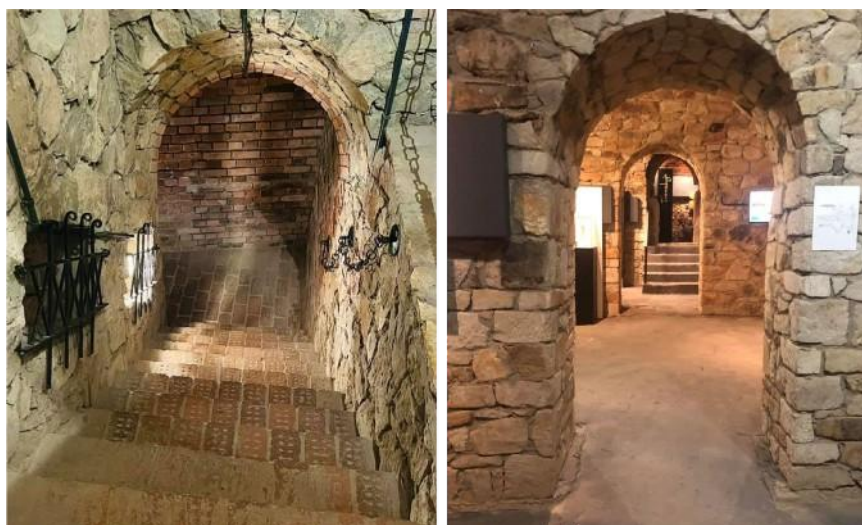
Widok zabytkowych fragmentów wyrobisk Podziemnej Trasy Turystycznej ( www.facebook.pl/PodziemniaOpatowskie )
