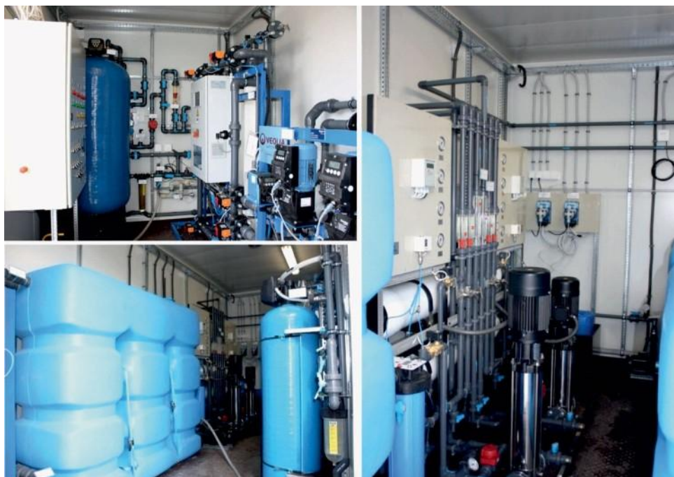
Modułowy system odsalania wód geotermalnych
