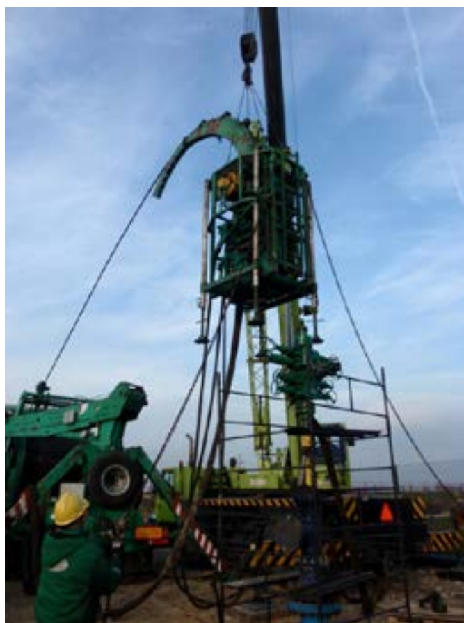
Fot. 9.2. Prace rekonstrukcyjne na otworze Skierniewice GT-1 z wykorzystaniem przewodu coiled tubing (fot. B. Bielec)
