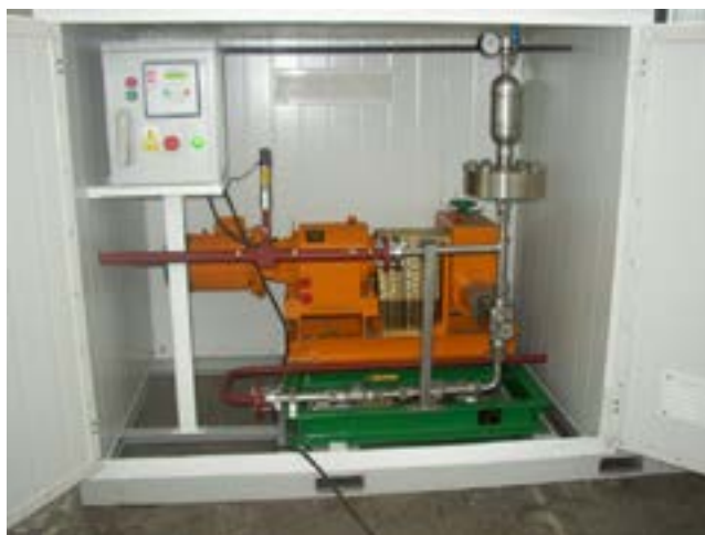
Fot. 9.1. Stanowisko pompowe i kontrolno-pomiarowe do zabiegów „miękkiego kwasowania” (fot. Graczyk, Bujakowski i in. 2008)
