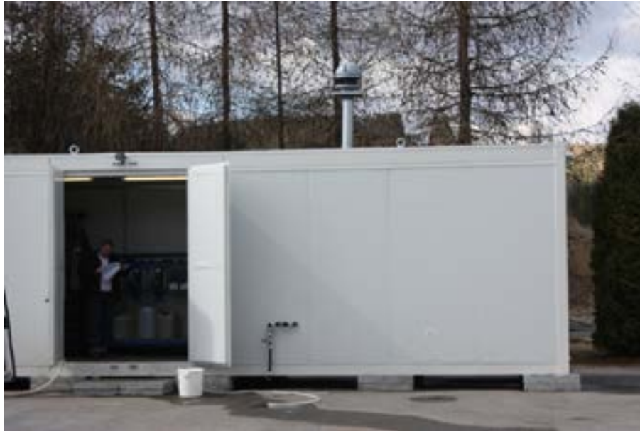
Fot. 9.3. Kontener stanowiska uzdatniania wód geotermalnych (fot. B. Tomaszewska)
