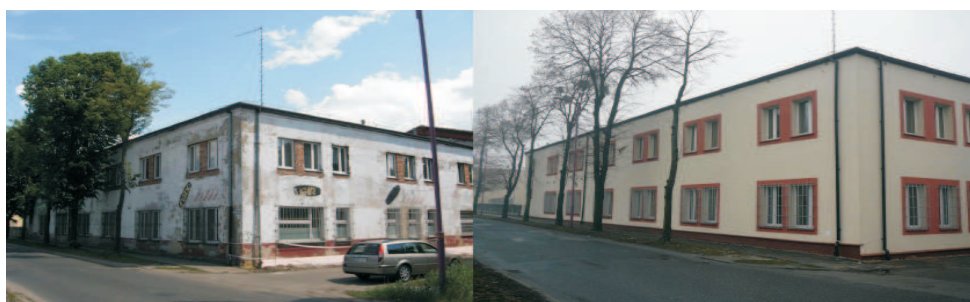
Rys. 5. Renowacja budynku Zakładu CZOK
